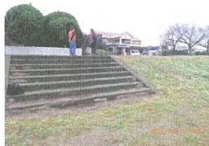
施設前の河川護岸(上から5段目まで水が来ると警戒, 1段目に達すると避難開始を一律決めていた)
