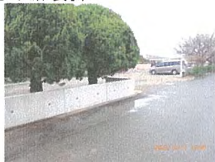
設置された防水壁(2023年12月11日撮影)
