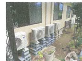
エアコン室外機の交換作業 (2023年7月21日撮影)
