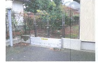
防水板(0.45m)設置状況 (2023年12月21日撮影)
